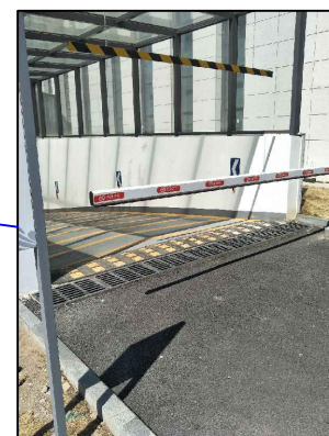
车库入口排水沟
