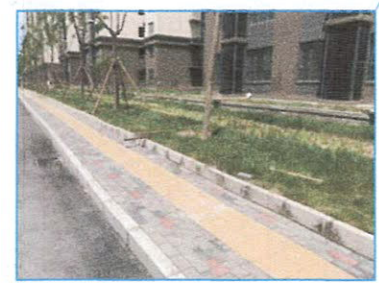
代建道路透水铺装 0.08hm 2
