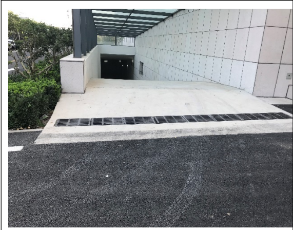
地库出入口截水沟
