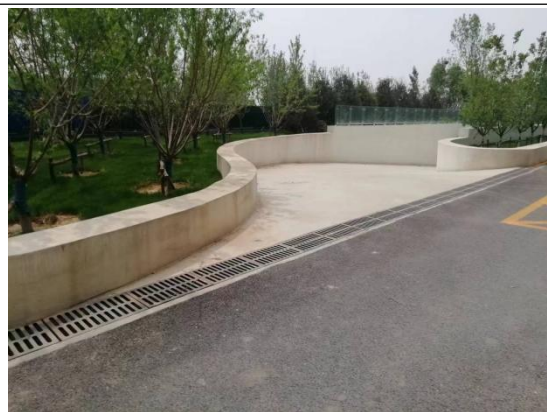
地库出入口截水沟
