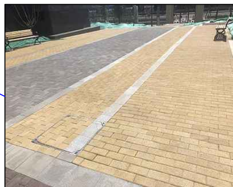
人行道透水铺装
