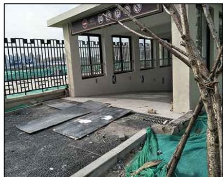
车库入口排水沟
