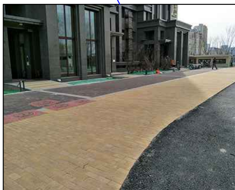
人行道透水铺装
