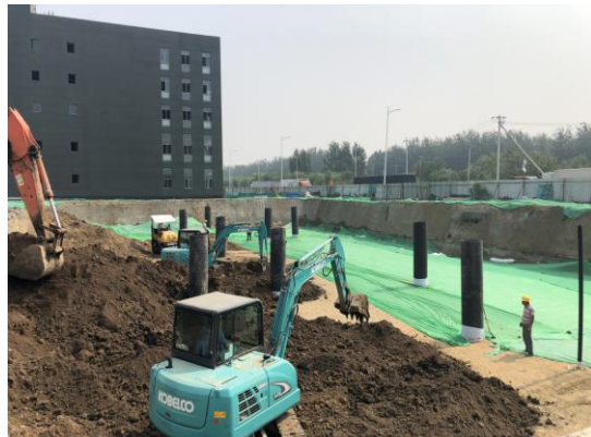
集雨池 2 及配套沉沙池 2
