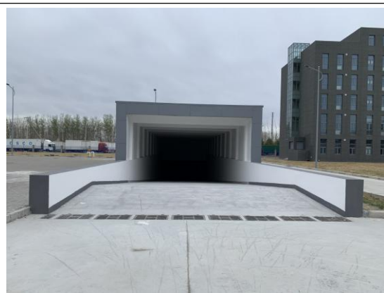
地下车库出入口排水沟（1）
