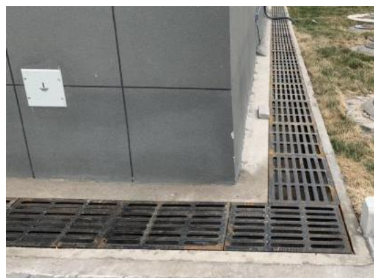
建筑物周边排水沟（1）
