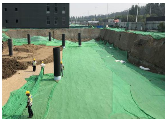
集雨池 1 及配套沉沙池 1
