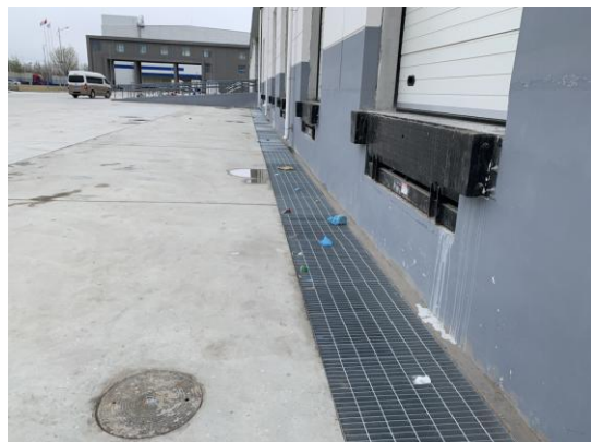
建筑物周边排水沟（2）
