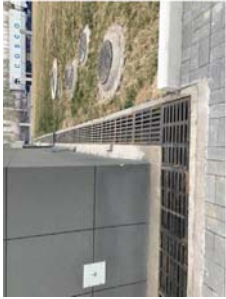
建筑物周边排水沟
