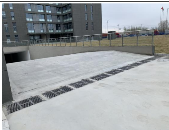
地下车库出入口排水沟（2）
